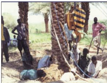
عملية تجهيز الخندق
